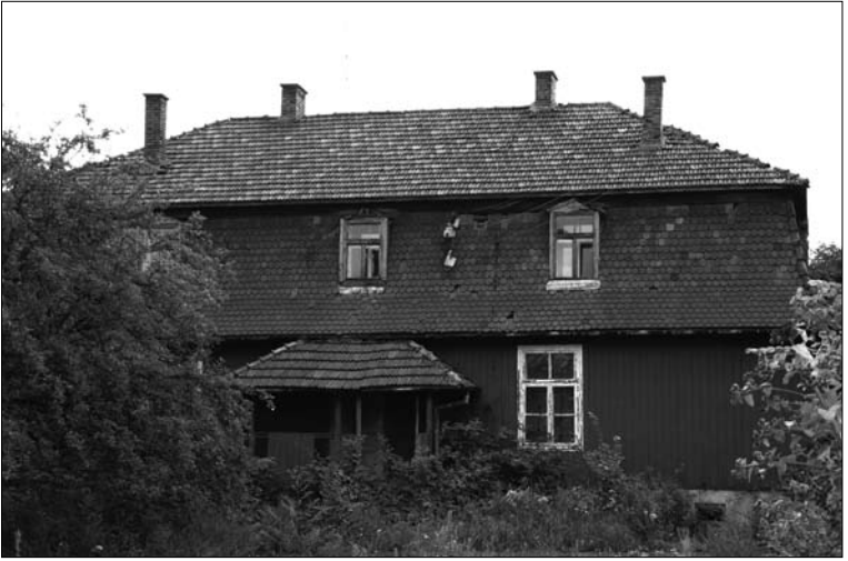
Wzniesiony w roku 1933 budynek szkoły podstawowej w Biórkowie Wielkim. Stan z roku 2007, kiedy nie był już użytkowany.
